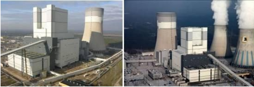
Widok Placu Budowy Bloku 858 MW
